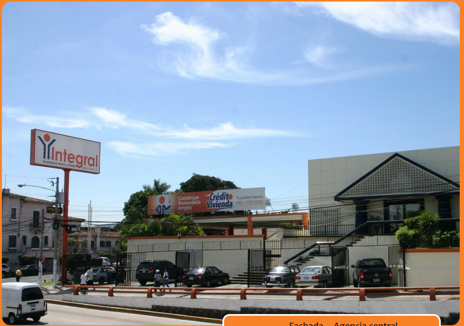
Fachada Agencia central
