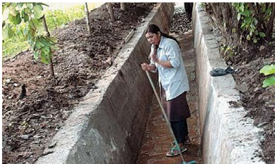
LIMPIEZA DE CANALETA CONSTRUIDA EN SECTOR SUR
