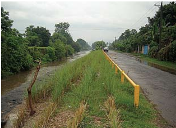
VISTAS DE LAS OBRAS DE CONFORMACIÓN DEL LECHO DEL RÍO.
