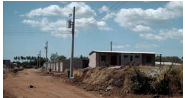
CONSTRUCCIÓN DE RED DE ENERGÍA ELÉCTRICA PARA LAS 260 VIVIENDAS
